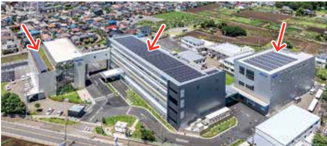
埼玉事業所の太陽光発電システム
