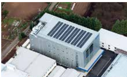
医療関連機器生産棟
