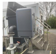
写真4: 最終放流水測定点に設置されたNH6000sc
