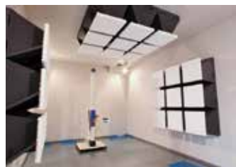
EMC 試験設備
