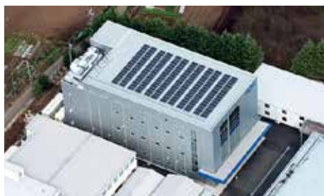
医療関連機器生産棟
