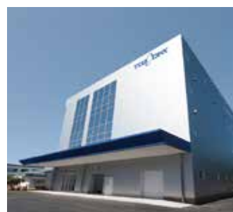
医療関連機器生産棟
