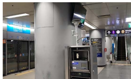
地下鉄駅構内 9 か所
