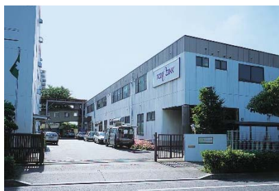
東京エンジニア リングセンター
