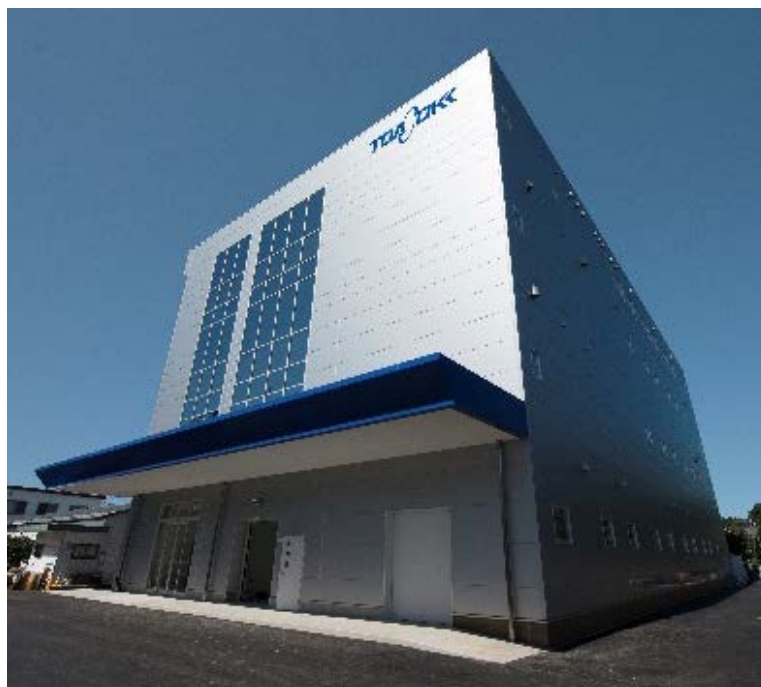
医療関連機器生産棟 (2017年10月稼動)
