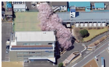
狭山テクニカルセンター・開発研究センター
