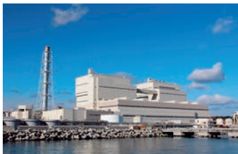
復興後の原町火力発電所
