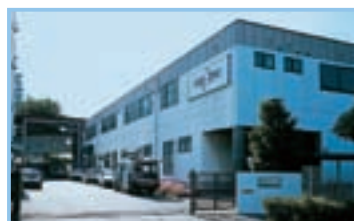
■ 東京エンジニアリングセンター
