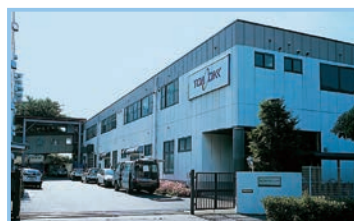
■ 東京エンジニアリングセンター
