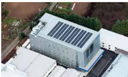
医療関連機器生産棟
