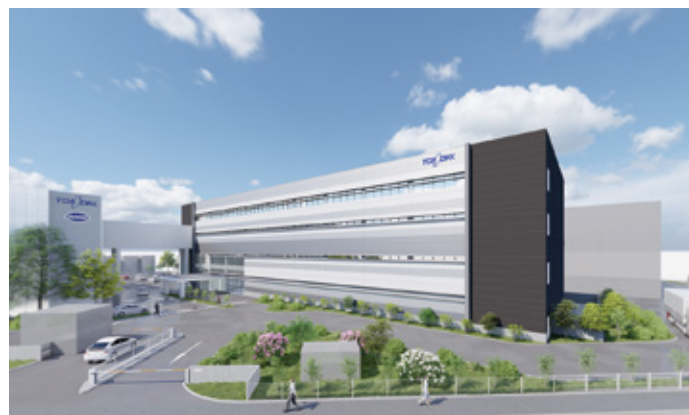
埼玉県狭山市に建設中の新生産棟のパス（2024年竣工予定）
