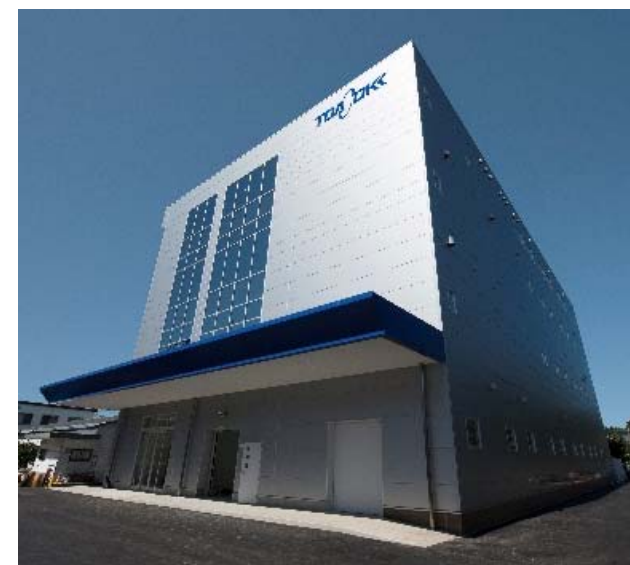
医療関連機器生産棟 (2017年10月稼動)
